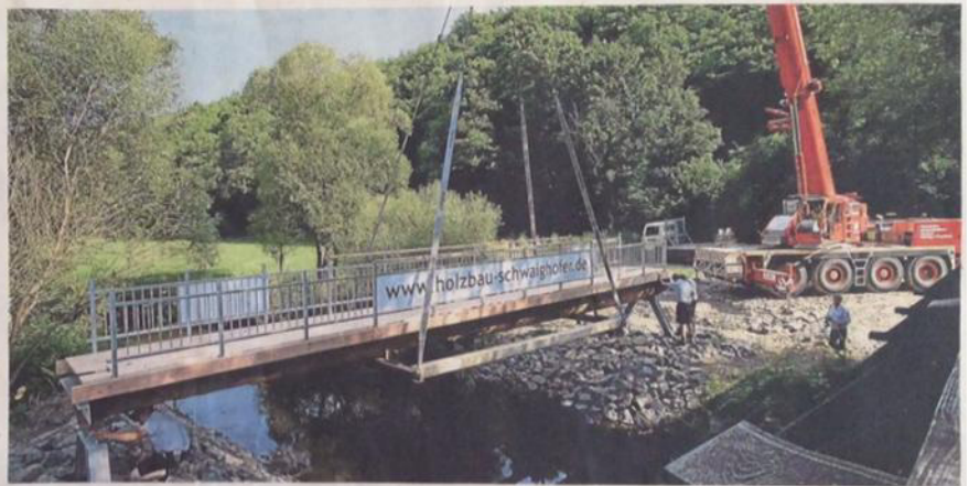
Um die 5,5 Tonnen wiegt alleine der 13 Meter lange Baumstamm, auf dem die neue Brücke über den Hahnenbach nahe der Hellkirch ruht, die ein Kran in der vergangenen Woche auf die beiden Stahlböcke gehoben hat.
