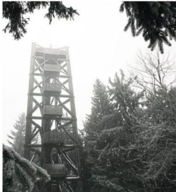
Der Aussichtsturm auf dem Idarkopf ist bei einem Brand im Oktober 2018 schwer beschädigt worden. Eine Reparatur kommt nicht infrage. Nun soll ein Neubau errichtet werden.
