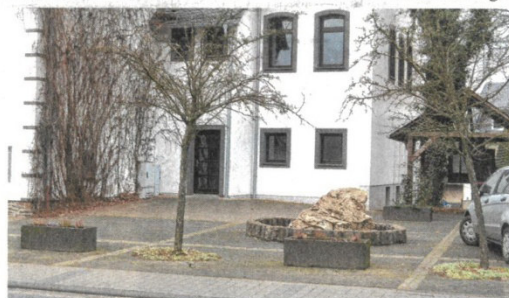
Hier, direkt am Gemeindehaus, soll bis zum Sommer der neue Dorfladen samt Dorf-Treff entstehen.
