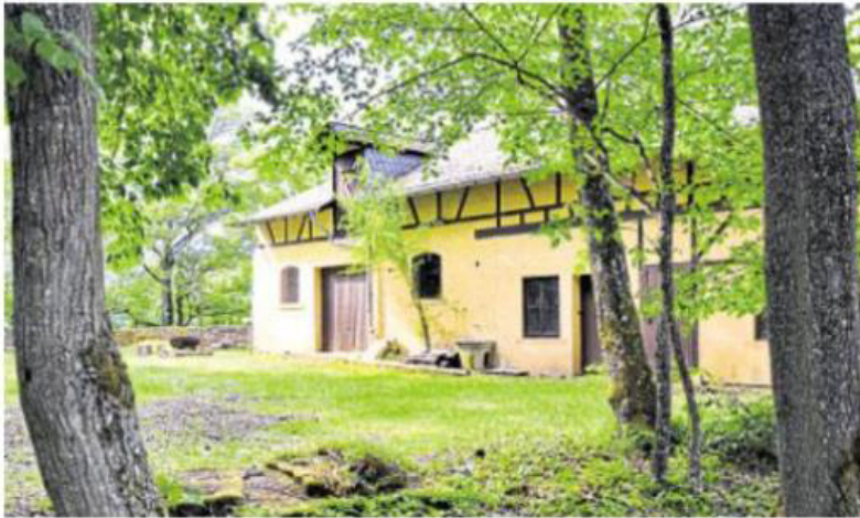
Die Remise im Park von Schloss Dhaun soll die Funktion des jetzt abgehakten Pavillonneubaus übernehmen. Für das neue Gesamtkonzept am Hildegardweg werden dann erneut EU-Leader-Mittel beantragt. Foto: Armin Seibert
