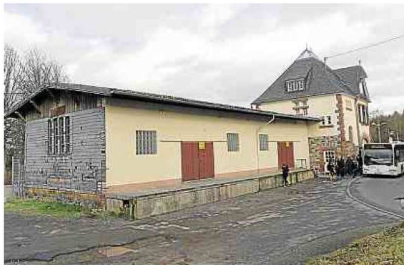
Sobald der Güterschuppen am Emmelshausener Bahnhof saniert ist, soll er eine Dauerausstellung über die Hunsrückbahn beherbergen. Foto: S. Breitbach
