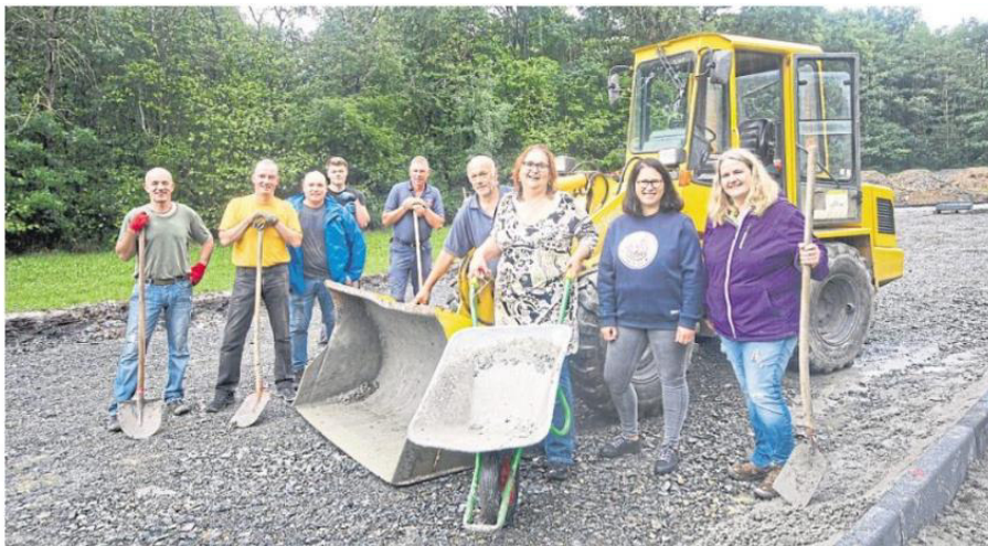
Ehrenamtliche Helfer haben auf dem Außengelände des Freibades mit den ersten Maßnahmen begonnen und die Randsteine für einen Wohnmobilstellplatz gesetzt.
