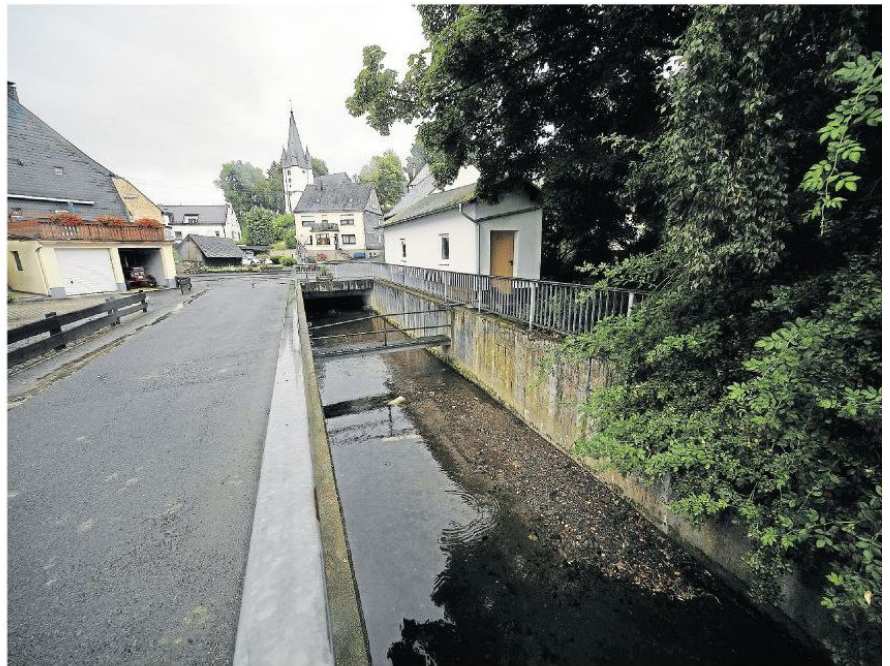
Dunkle Wolken über Rhaunen. Doch dafür gibt es eigentlich gar keinen Grund. Der Rhaunelbach soll mithilfe von Zuschüssen aus diversen Förderpro-grammen umgestaltet werden. Der Baubeginn soll im Frühjahr 2017 erfolgen.
