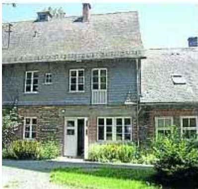
Die Gebäude des VBS Sohrschied sind in die Jahre gekommen. Jetzt werden sie saniert.
