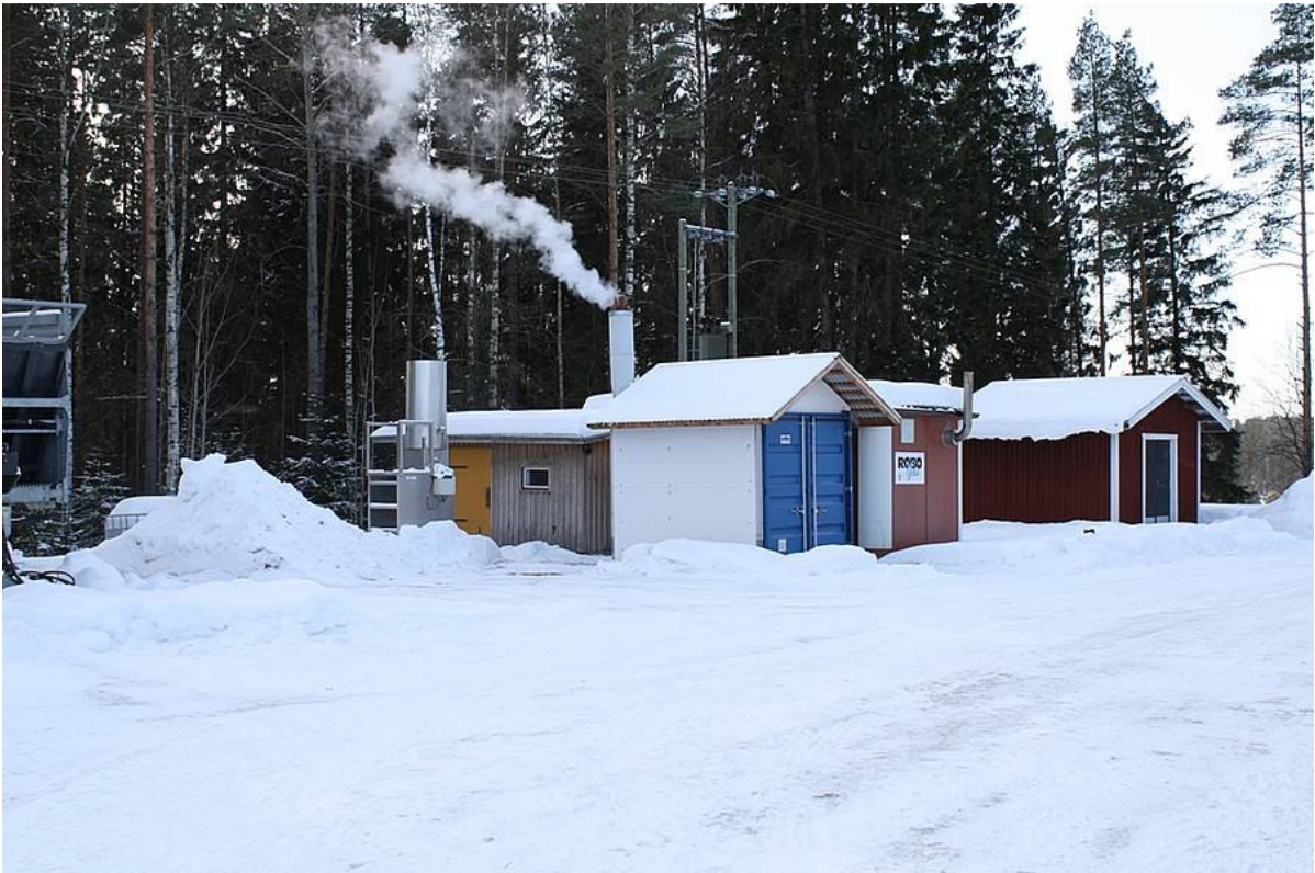
Abfallstoffe aus der Milchviehhaltung eignen sich gut zum Betrieb einer hofeigenen Biogasanlage
