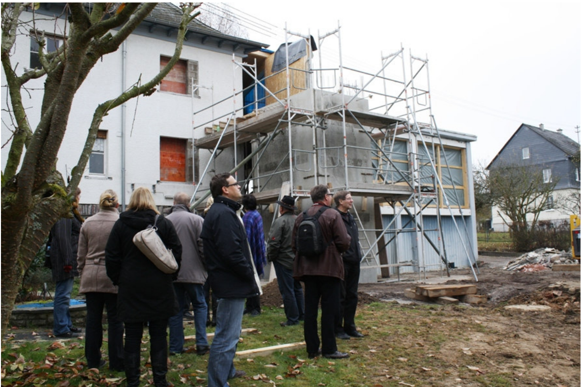
Besichtigung der Baustelle der Senioren-Wohngemeinschaft Külz
