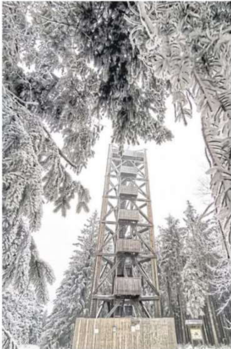
Der bei einem Brand im Oktober 2018 beschädigte Aussichtsturm soll durch einen Neubau ersetzt werden.
