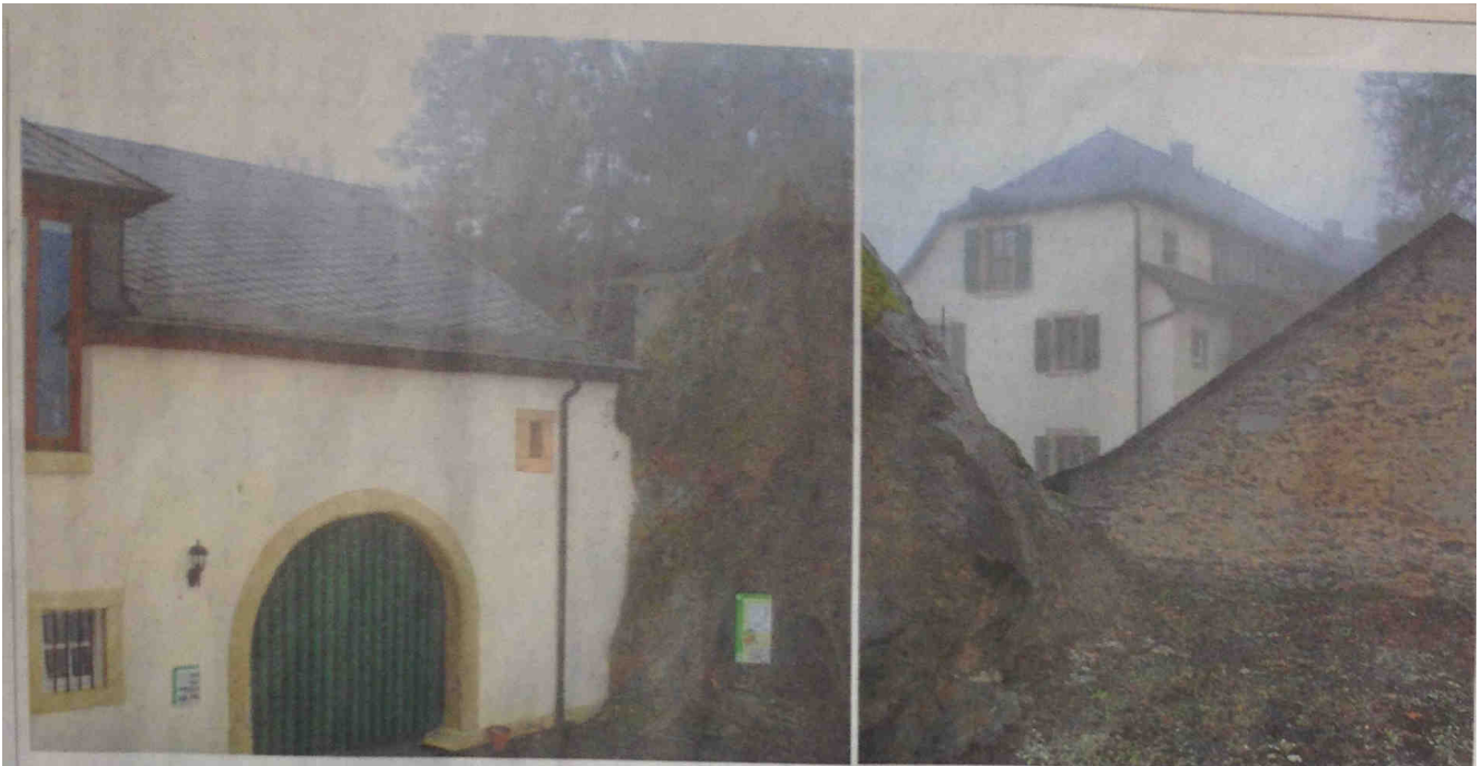
Im Anschluss an die Veranstaltungsscheune im Innenhof von Schloss Wartenstein (Foto links) wird hinter die Felsnase ein Anbau mit Küche, Dusche und Schlafräumen gebaut, um Aktionen wie Umweltcamps zu ermöglichen. Rechts eine Ansicht der Gebäude von der Rückseite her. Fotos: Sascha Saueressig
